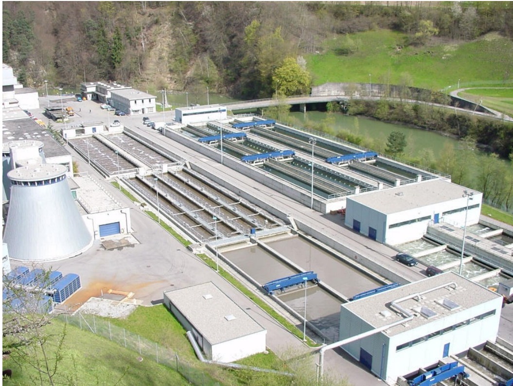
STEP station d'épuration des eaux
