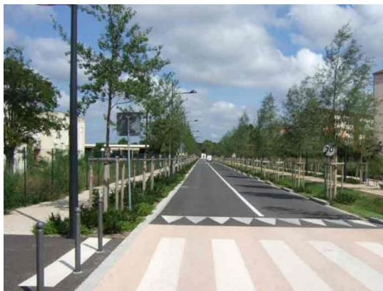
Aménagement des Boulevards de l'Ouest, Sathonay-Camp (France)
