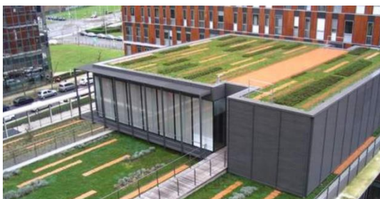
Immeuble du ministère des Finances à Noisy-le-Grand
