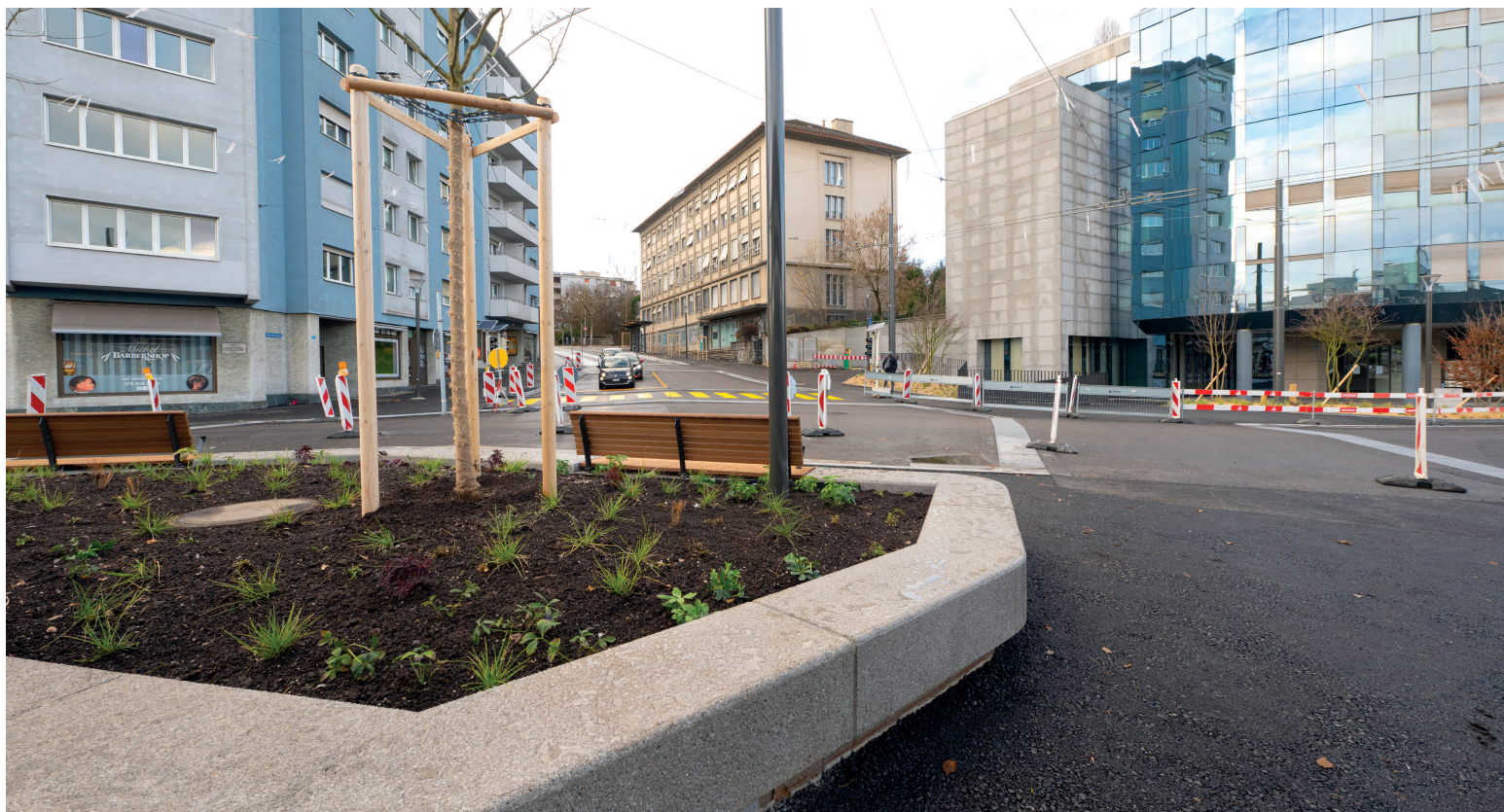
Ultime étape du chantier, la couche de roulement sera posé ce printemps. Der Einbau der Deckschicht wird im nächsten Frühjahr durchgeführt. © Ville de Fribourg/Valentine Brodard
