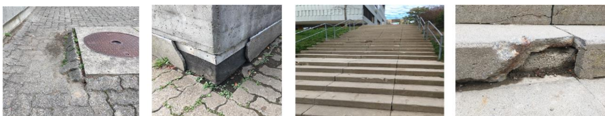
Figure 6 : constat aménagements extérieurs
