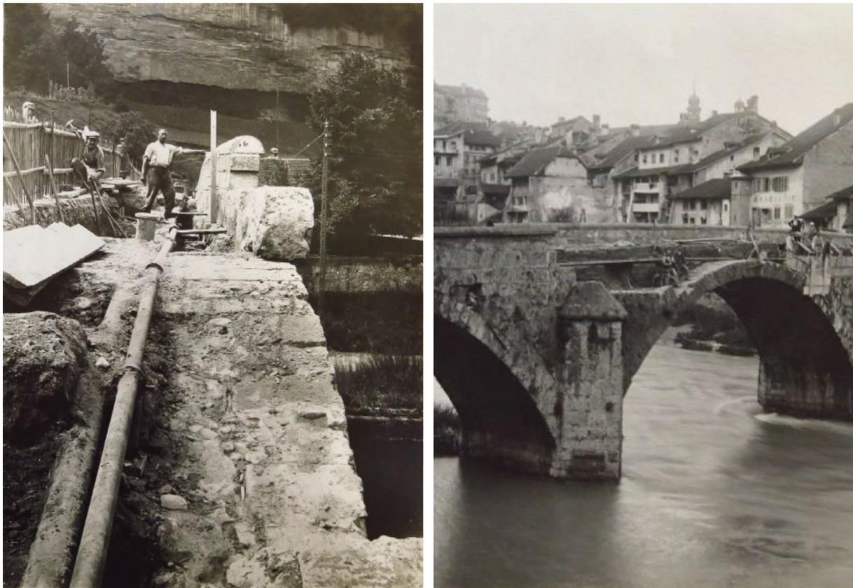
Figure 17 : Pont du Milieu – Reconstruction du parapet, 1933
