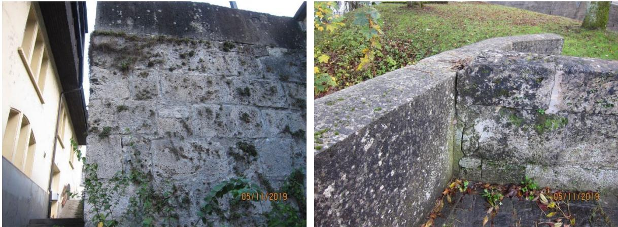
Figure 22 : Fissure verticale (côté aval) et faux aplomb du mur en retour coté amont
