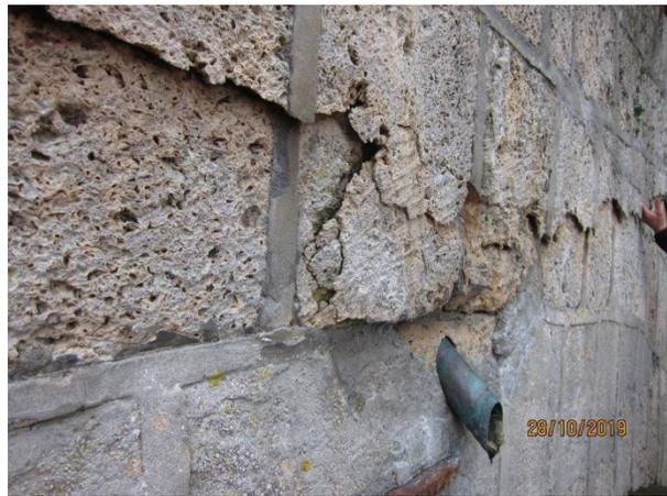
Figure 20 : Fissure avec déplacement hors plan coté aval
