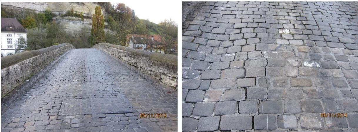
Figure 23 : Pavage-affaissement, dégradation mortier d'assise, fissures gauches
