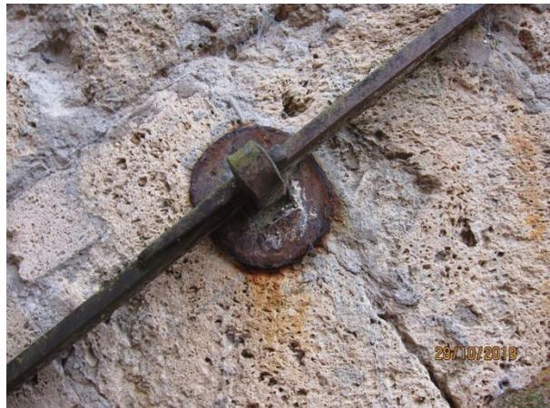
Figure 21 : Corrosions ferrures avec perte de section – coté amont (gauche) et coté aval (droit)
