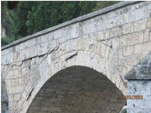
Figure 19 : Fissure avec déplacement hors plan coté amont
