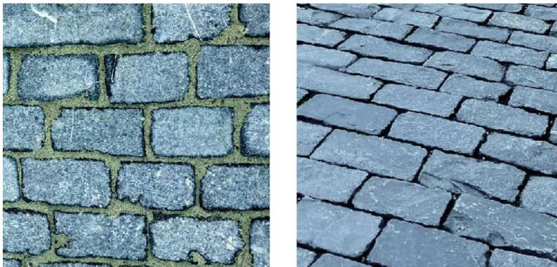
Figure 12 : Gauche, pavés sciés flammés – Droite, pavés bruts
